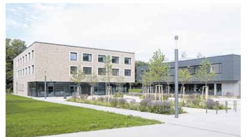
Ein Blick auf das Gästehaus und das Werkstattgebäude.
